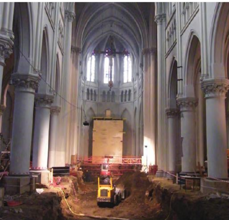
■ Werkzaamheden in de Minderbroederskerk te Mechelen om de herbestemming als hotel mogelijk te maken. © Ezioman
